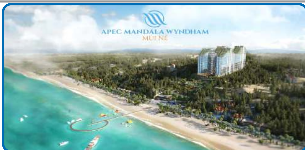
Dự Án: Apec Mandala Wyndham Mũi Né
